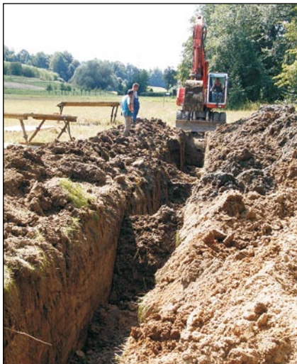
Prace przy kanalizacji w Hażlachu • Fot. GK
