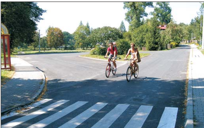
Nowa nawierzchnia na ulicy Kościelnej i w zatoce autobusowej • Fot. GK
