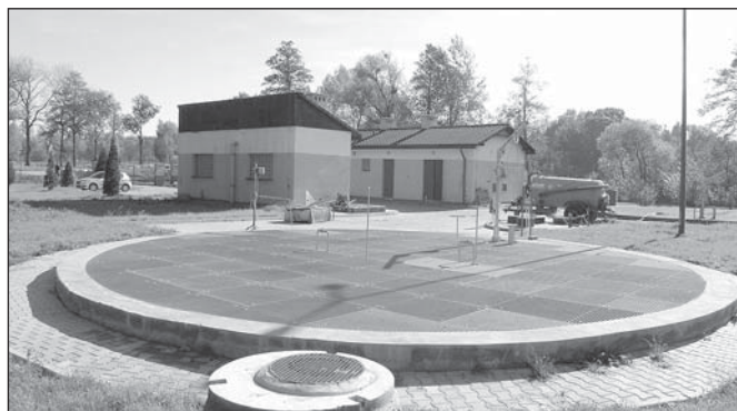
Drugi zbiornik oczyszczalni ścieków w Hażlachu • Fot. GK
